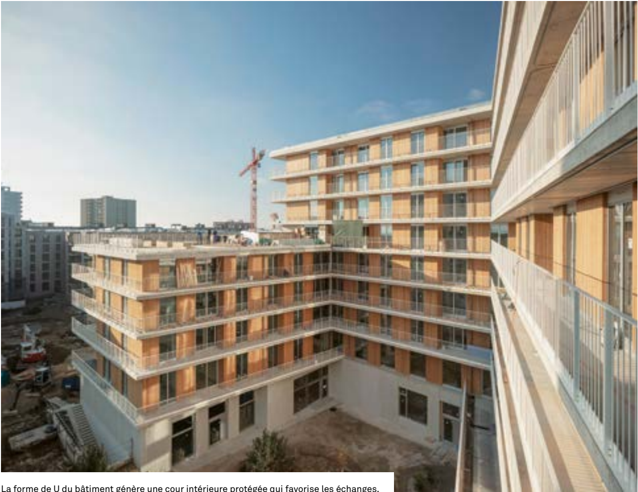
La forme de U du bâtiment génère une cour intérieure protégée qui favorise les échanges.
