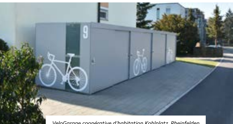
VeloGarage coopérative d'habitation Kohlplatz, Rheinfelden
