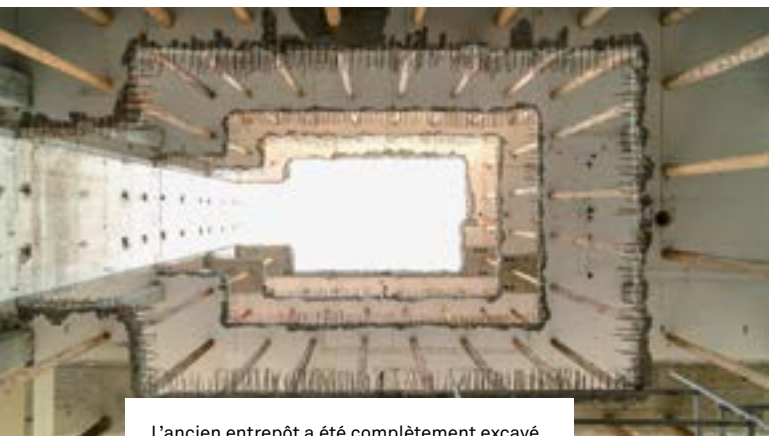
L'ancien entrepôt a été complètement excavé.
